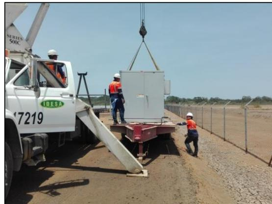
**Imagen 5-6 reparación de Transformador Principal PSS**
